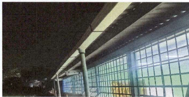
Foto 2: Sustrucción de canal de pvc
