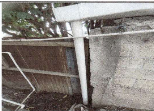
Foto 3: Reparación de bajada de agua pluvial, tubo de pvc 3"
