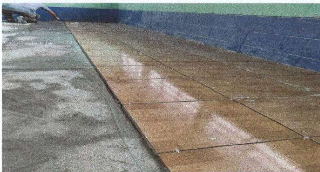
Foto1: Sustrucción de piso Ceramico
