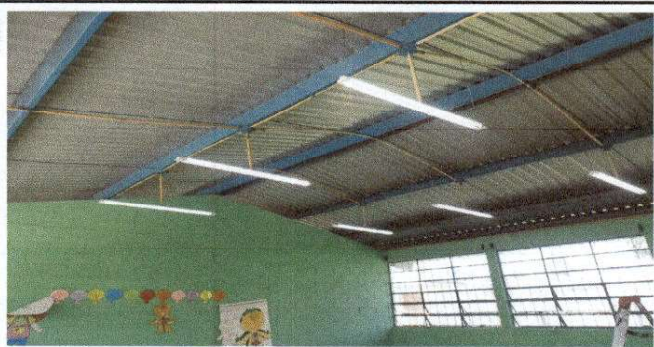
Foto 5: Sustrucción de lamparas de 2 x 40
