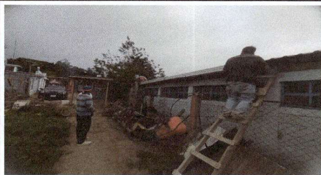
Foto 4: Sustrucción de soporte o pescante de metal para canal
